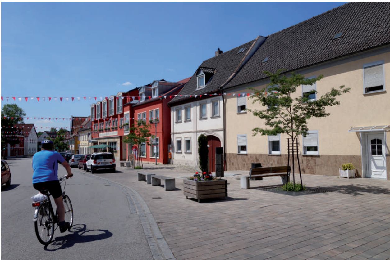
Memmelsdorf, Beispiel Straßensanierung mit Brunnen
