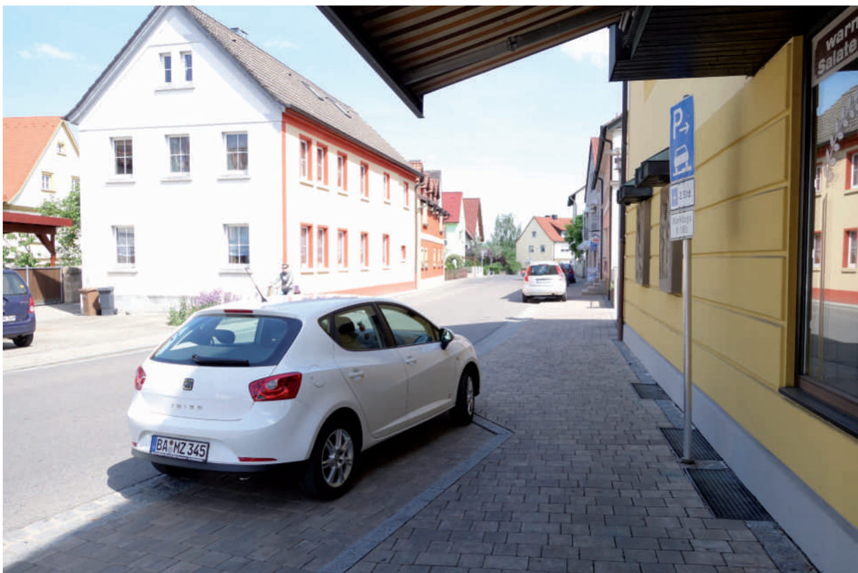
Memmelsdorf, Beispiel Straßensanierung
