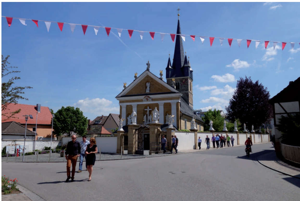
Memmelsdorf, Beispiel Straßensanierung
