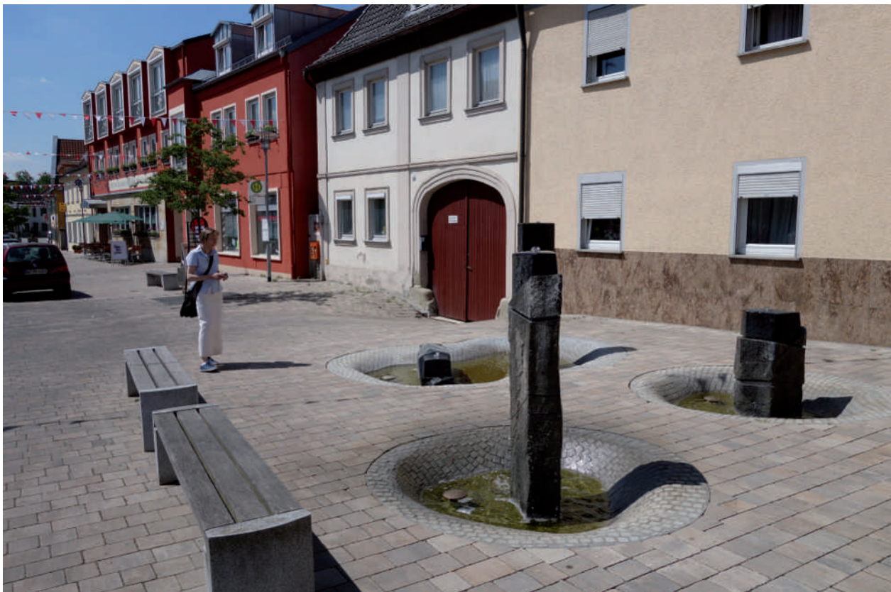
Memmelsdorf, Beispiel Straßensanierung mit Brunnen
